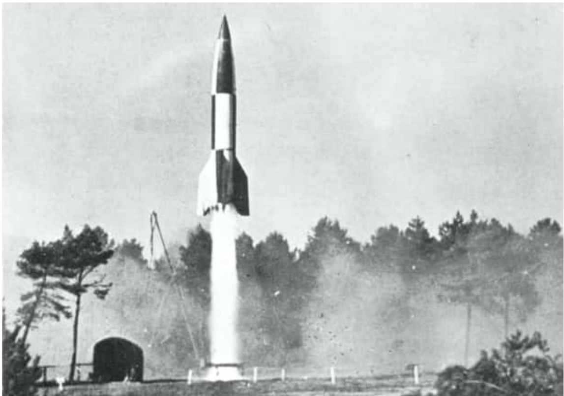
O Vergeltungswaffe 2 (V-2) era impulsionado por um motor de foguete
