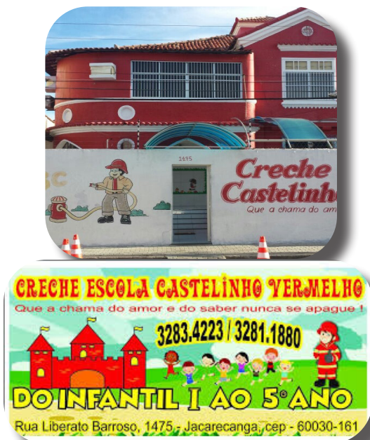
Figura 43 – Frente da Creche Escola Castelinho Vermelho
